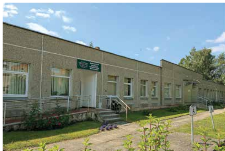
Teisėjų taryba siūlo teismą perkelti į savivaldybei priklausančią pastatą Dariaus ir Girėno g. 120A, su sąlyga, kad savivaldybė savo lėšomis sutvarkys pastato išorę, išplės automobilių parkavimo aikšteles ir pritaikys patalpas teismo veiklai. Redakcijos nuotraukos.
